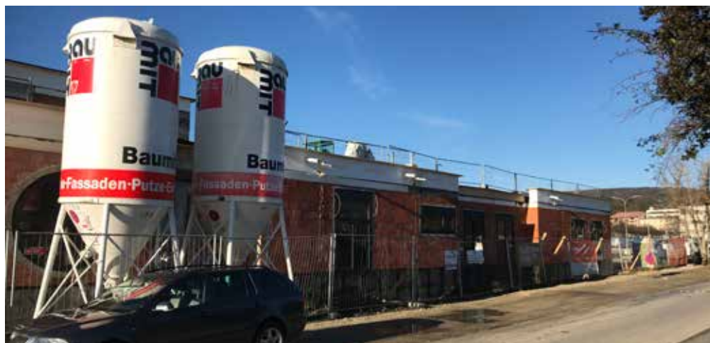
Eisenstadt baut gerade einen Kindergarten, wir wollen 2019 starten
